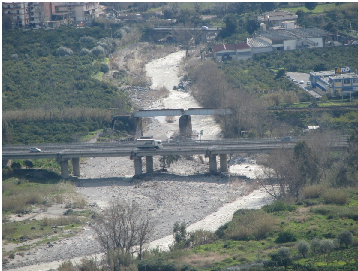
Ponti su fiume 'Alcantara : in primo piano il ponte dell'autostrada A 18, segue quello ferroviario RFI , in fondo quello della SS. 114 (al Km 54.)
